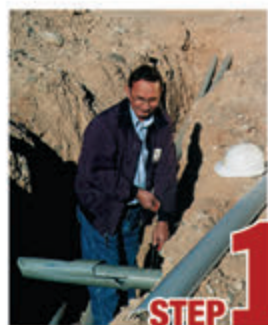
STEP 1 Remove damaged conduit
