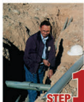
STEP 1 Remove damaged conduit
