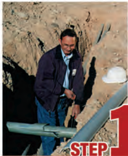
STEP 1 Remove damaged conduit
