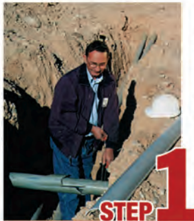
STEP 1 Remove damaged conduit
