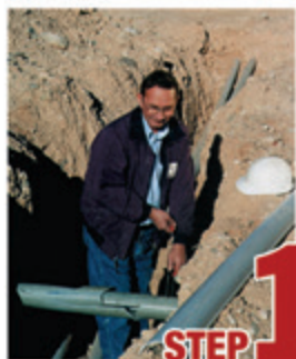
STEP 1 Remove damaged conduit
