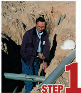
STEP 1 Remove damaged conduit
