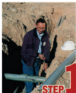
STEP 1 Remove damaged conduit
