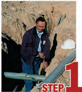
STEP 1 Remove damaged conduit
