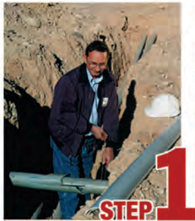
STEP 1 Remove damaged conduit
