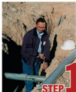
STEP 1 Remove damaged conduit
