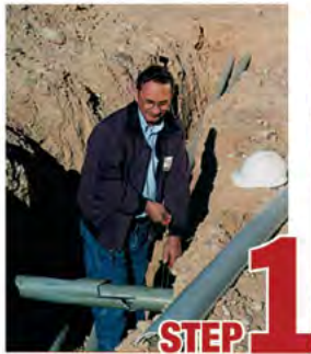
STEP 1 Remove damaged conduit
