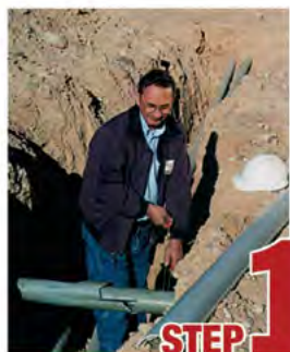
STEP 1 Remove damaged conduit
