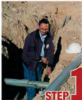
STEP 1 Remove damaged conduit
