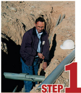
STEP 1 Remove damaged conduit
