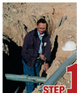
STEP 1 Remove damaged conduit
