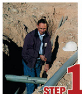
STEP 1 Remove damaged conduit
