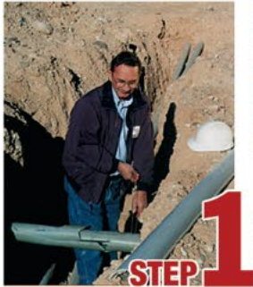
STEP 1 Remove damaged conduit
