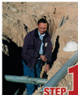
STEP 1 Remove damaged conduit
