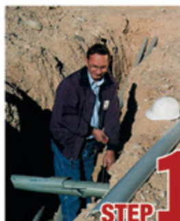
STEP 1 Remove damaged conduit
