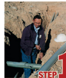
STEP 1 Remove damaged conduit
