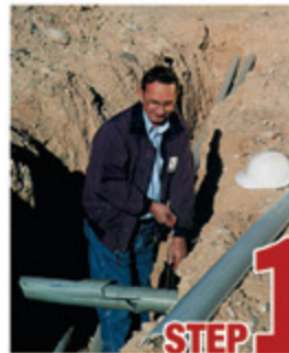
STEP 1 Remove damaged conduit
