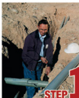
STEP 1 Remove damaged conduit
