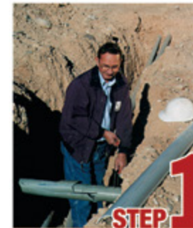
STEP 1 Remove damaged conduit
