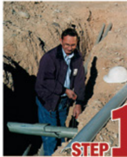
STEP 1 Remove damaged conduit
