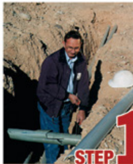
STEP 1 Remove damaged conduit
