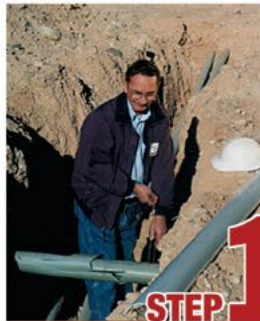
Remove damaged conduit
