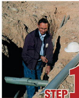
Remove damaged conduit
