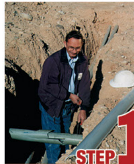
STEP 1 Remove damaged conduit
